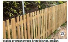
Staket av organowood kring lektyr, omalat. Höjd 900mm. Höjd kring rundeln 1200mm för att hejda bollar.
